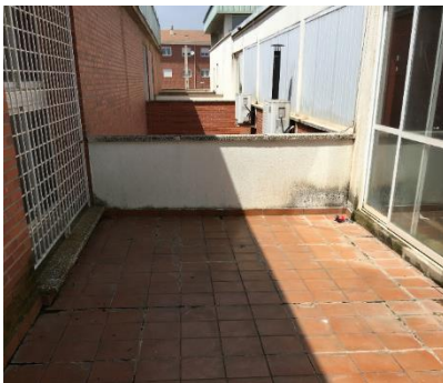
Manchas de humedad en fachada lateral, edificio de servicios.
